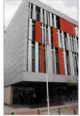
Edificio de la FUE-UJI. EUGENIO TORRES
